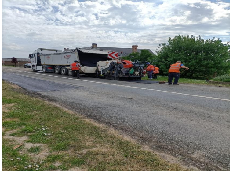
Réfection voirie RD946, à charge du Département
